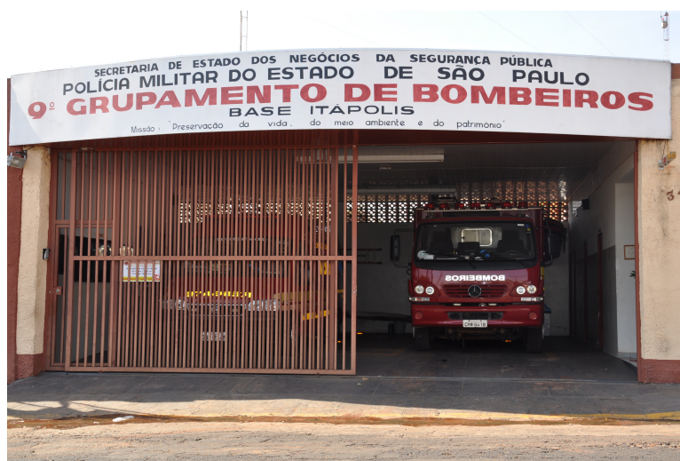
Fachada da Base Operacional do Corpo de Bombeiros de Itápolis
