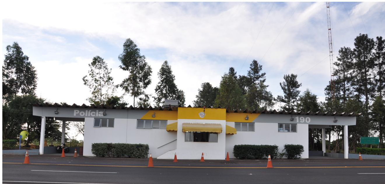
Base Operacional da Polícia Militar Rodoviária do Estado de São Paulo, localizada na Rodovia SP-333, próximo ao trevo de Itápolis-Tapinas
