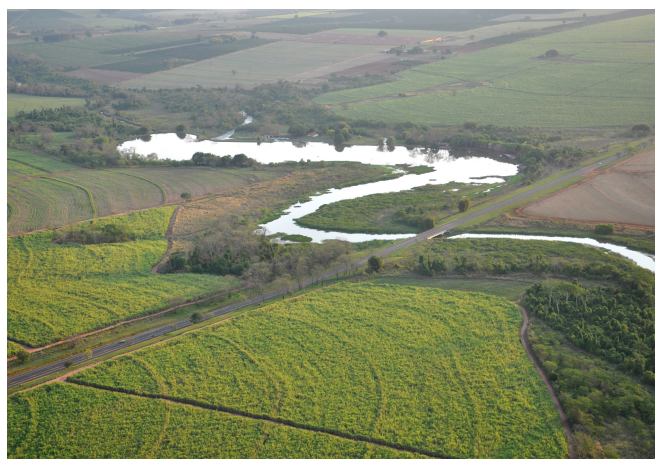
Represa da Usina da Light, no Ribeirão dos Porcos
