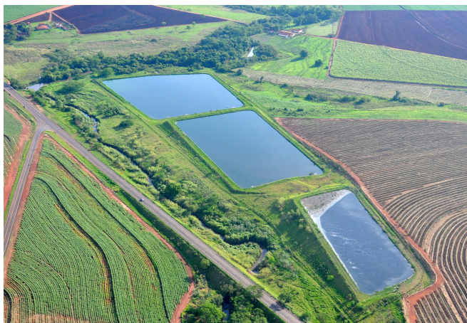
Lagoas de estabilização do tratamento de esgoto
